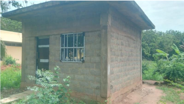
Figure 1 : local en parpaings creux de béton de balle de riz
