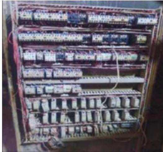
Fig. 1. Ancienne Armoire avec logique câblée
