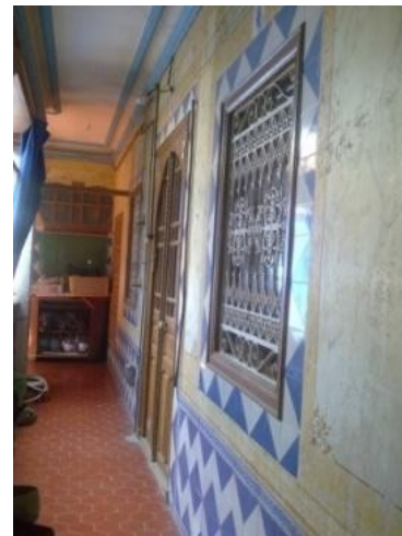
Fig. 27: La galerie (Satha), maison Benchicou. Source : LAID Hichem, 2012
