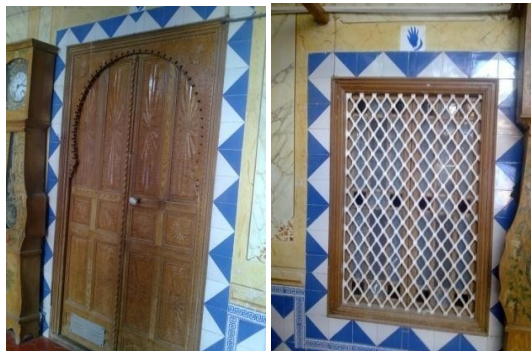
Fig. 25 & 26 : Vue d'extérieure porte et fenêtre, Chambre maison Benchicou. Source : LAID Hichem, 2012.
