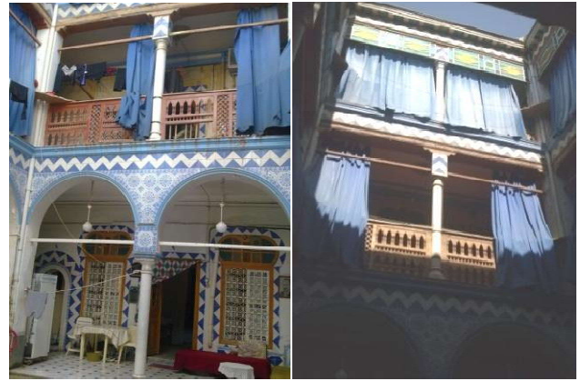
Fig. 19 & 20 : Les façades intérieures présent à partir du patio maison Benchicou Source : LAID Hichem, 2012
