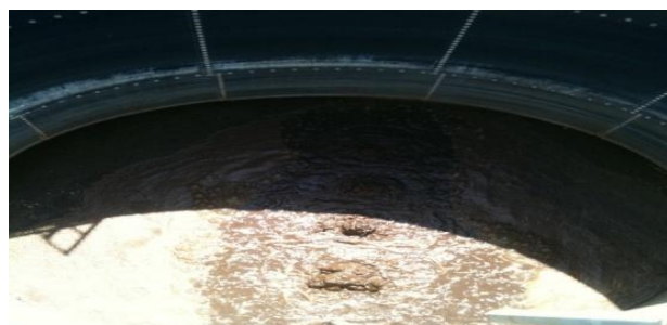
Fig.4. Sanitary water deposits Dépôt des eaux sanitaires
